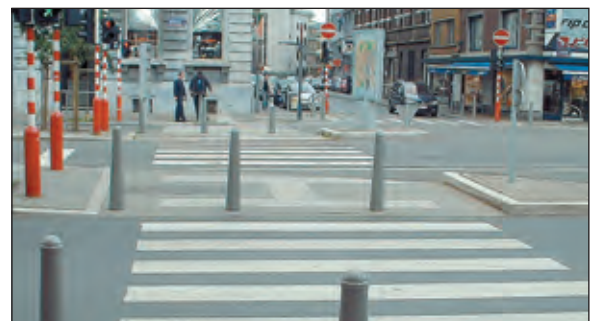
Figures 3 et 4: implantation type des dalles dans des traversées avec grands îlots rectangulaires. © GAMAH
