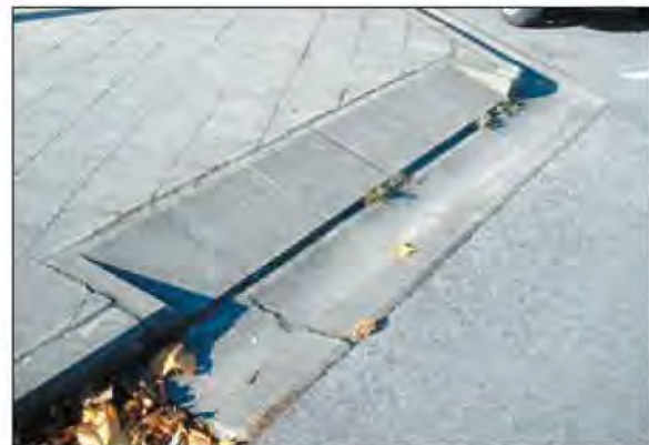
Figures 12 et 13: exemples de bateaux d'accès infranchissables en raison d'un ressaut. © GAMAH
