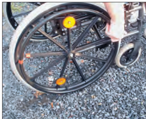
Figure 6: revêtement inadapté pour les personnes à mobilité réduite. © GAMAH
