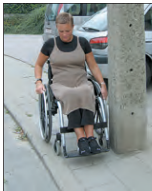
Figure 5: libre passage ponctuel inadapté. © Access+
