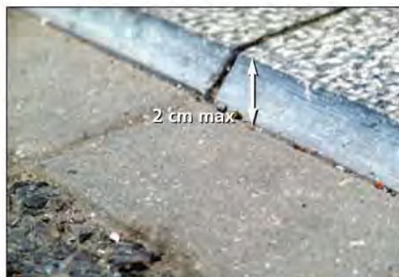
Figure 14: la rupture de niveau franchissable en chaise roulante est de maximum 2 cm chanfreinés ou arrondis.
