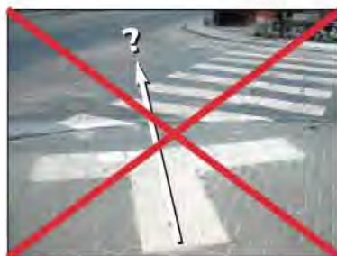
Figure 10: les dalles striées doivent indiquer l'axe de la traversée ! © GAMAH
