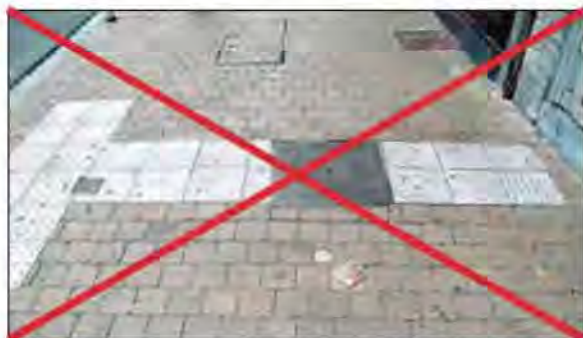
Figure 23 : dalle recouverte d'une plaque d'égout.
