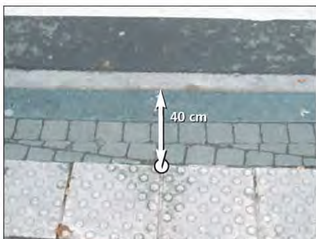
Figures 3 et 4: deuxième étape, le point d'attache, placé sur l'axe, à 40 cm du bord extérieur de la bordure. © GAMAH
