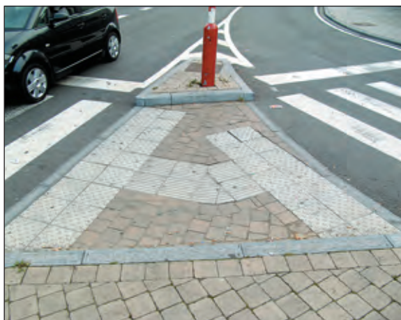
Figures 6 et 7: implantation type des dalles dans des traversées avec petits îlots triangulaires. © GAMAH et MET-D 434 (n°05/5265)
