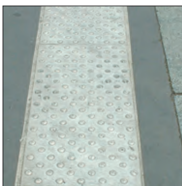
Figure 2: les dalles collées.
