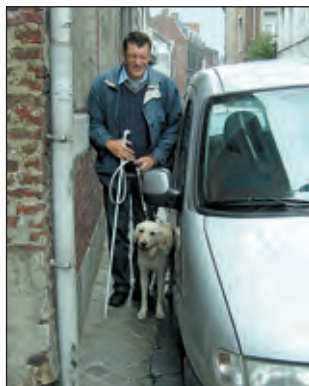
Figure 4: libre passage insuffisant pour les piétons. © Access+
