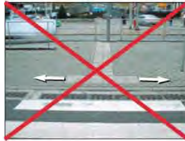
Figure 6: les dalles à protubérances doivent être placées sur toute la largeur de la traversée. © GAMAH
