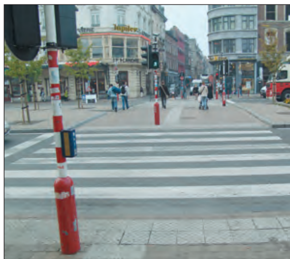
Figures 4 et 5: aménagement type des feux de signalisation. © GAMAH et MET-D 434 (n° 05/5257)
