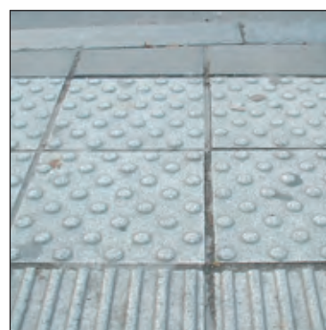
Figure 3: les dalles de béton (30 x 30 cm). © GAMAH
