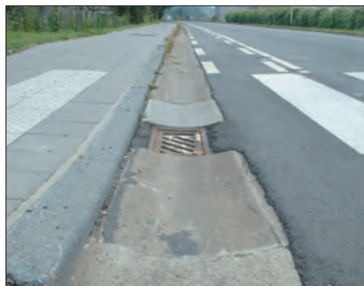
Figure 12: traversée inadaptée.
