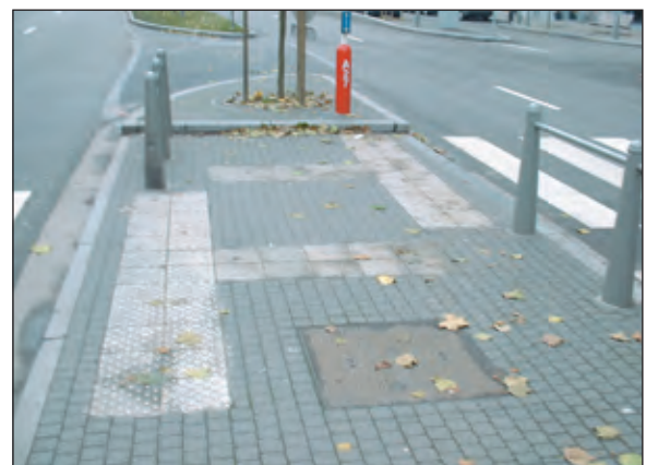
Figures 1 à 3 : implantation type des dalles dans des traversées en baïonnette. © GAMAH
