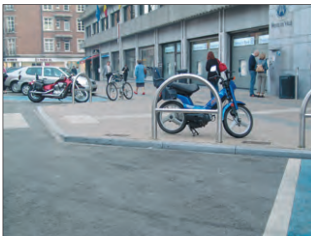
Figure 8: le trottoir doit être accessible aux PMR depuis le stationnement.
