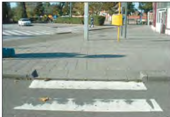
Figures 12 et 13: exemples de bateaux d'accès infranchissables en raison d'un ressaut. © GAMAH
