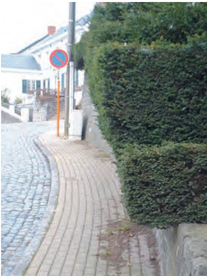
Figures 19 et 20: haies envahissantes, réduisant l'espace libre pour le piéton.
